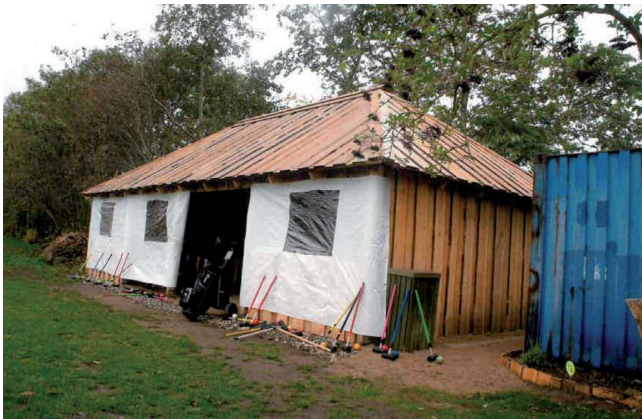
"Krolfhytten" er i 2015 under opførelse ved frivilligt arbejde.
