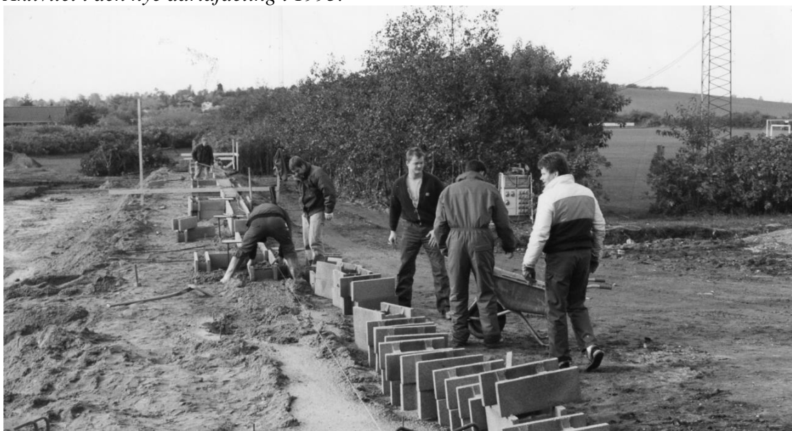
Foreningens medlemmer har påbegyndt det hårde arbejde med opførelse af Åstrup-Hallen.
